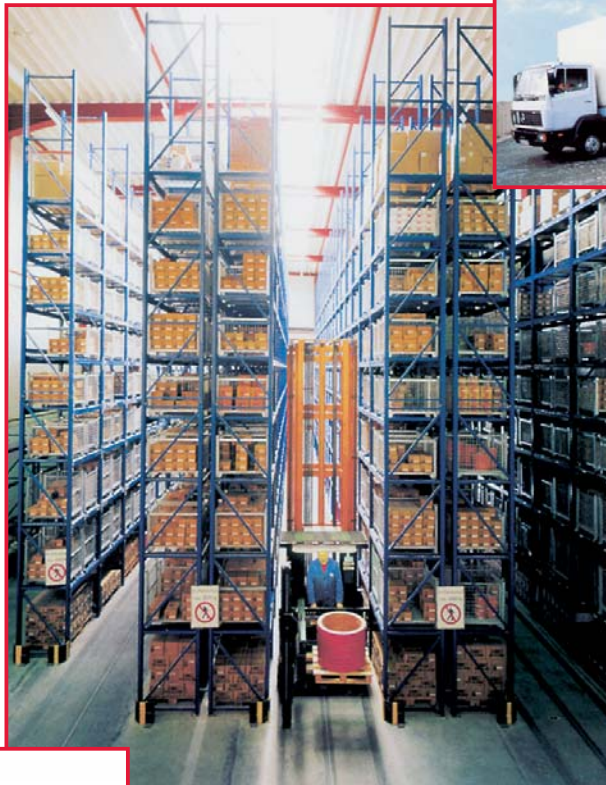
Das Mitte 1996 errichtete zentral-computergesteuerte Hochregallager
